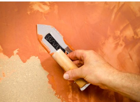
Lehm-Glätte mit der japanischen Glättkelle in Fleckspachtelung aufbringen
