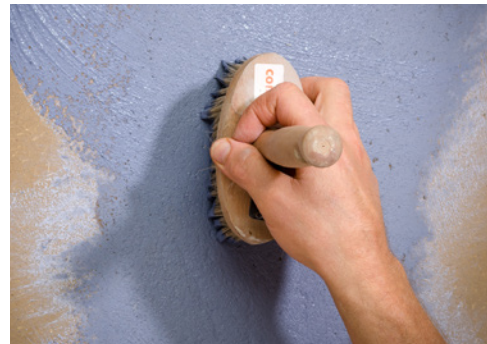
Lehm-Streichputz im Kreuzschlag auftragen
