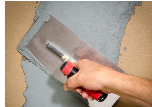
Edelputz mit der Edelstahl-Glättekelle auftragen
