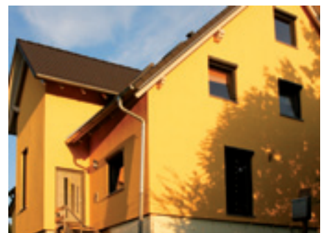
Gedämmt und fertig verputzte Fassade
